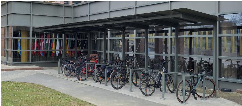
Standort unmittelbar am Eingang, von innen sichtbar und überdacht
