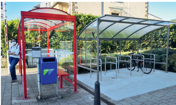
Überdachte Anlehnbügel an einer Bushaltestelle
