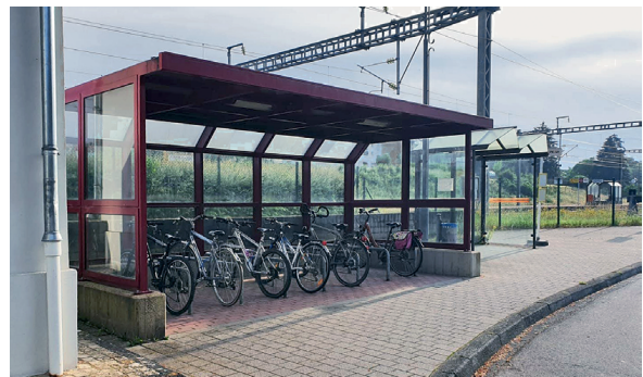
Überdachte Anlehnbügel an einem Bahnhof
