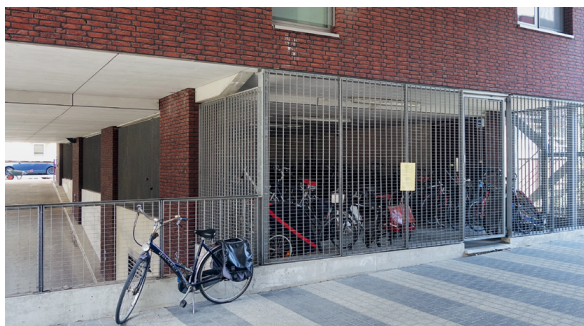
Am Gebäudeeingang (außerhalb der thermischen Hülle)
