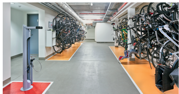
Derselbe Raum nach dem Umbau
