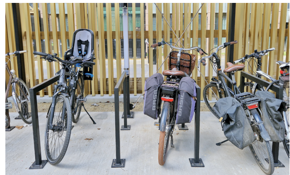
Achsabstand von nur 80 cm, daher keine 2 Fahrräder pro Anlehnbügel
