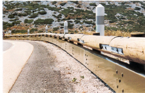
Ecran de Protection sous glissière métallique Ecran de Protection sous glissière en bois
