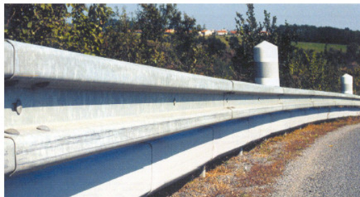
RAILPLAST monté sous glissière métallique
