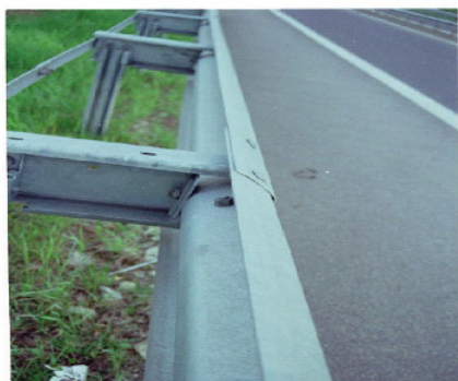
Bord agressif d'une planche
