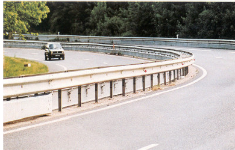
Ecran de Protection sous glissière métallique Ecran de Protection sous glissière en bois
