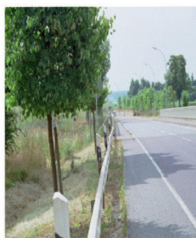
Réflecteurs sur glissière
